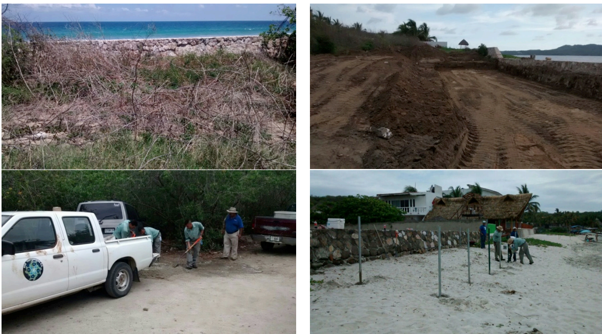
Figura 27. Preparación de terreno y colocación de estructura para el nuevo vivero de incubación de nidos de tortuga marina en Litibú.
