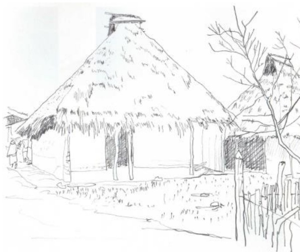
Estructura con techo de caballete, cuya inclinación es bastante pronunciada, el orificio superior facilita la salida de humo. San Juan Chamula
