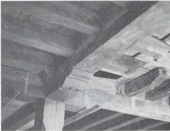
Estructura de madera
